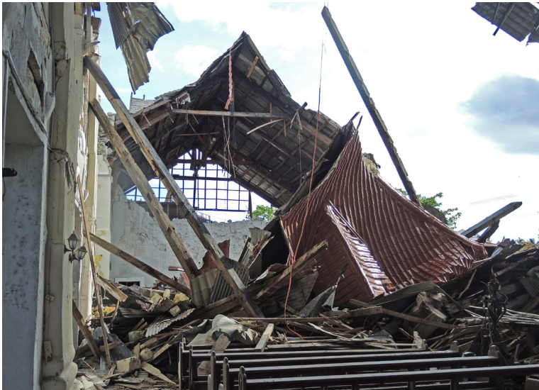
کلیماسایی که در اثر زلزله سال ۲۰۱۳ در بوهول، فیلیپین آسیب دیده است. عکس: اپرنا تندن، ICCROM
