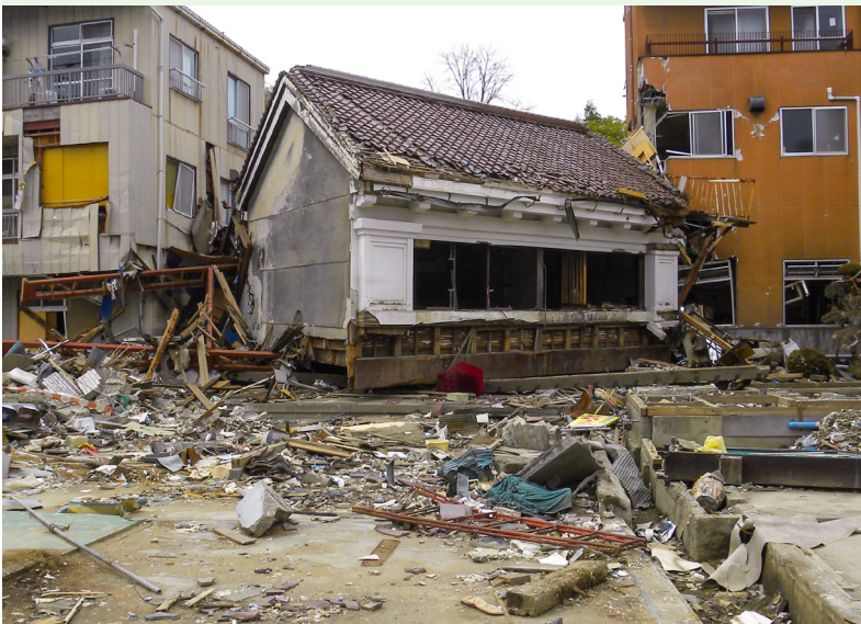
فروریختن ساختمان ناشی از سونامی در شرق ژاپن، ۲۰۱۱ عکس: هیئت مقام ریاست میاگی.
